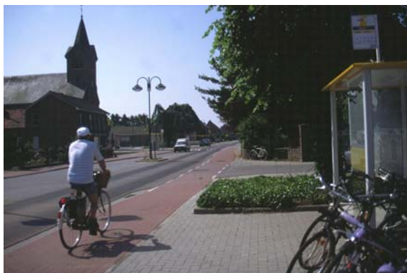
Foto 3.21 Aanliggend verhoogd fietspad – Linde - Peer
