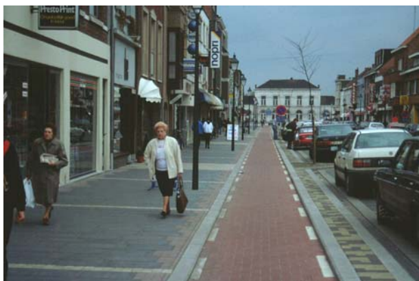
Foto 3.20 Strook tussen vrijliggend fietspad en parkeerstrook – Leopoldsburg
