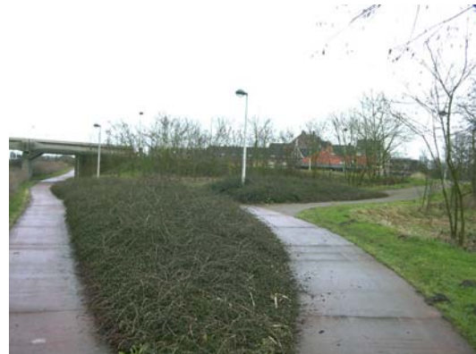
Foto 3.12 Gescheiden fietsvoorzieningen en ongelijkgrondse kruising fietspad - primaire weg - Peer
